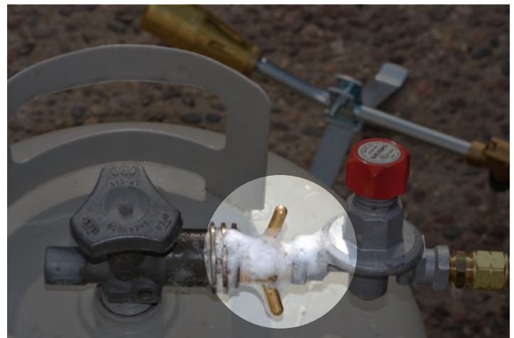
Prueba fugas con agua jabonosa.
